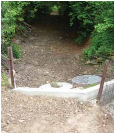
Nove cijevi i šahtovi
