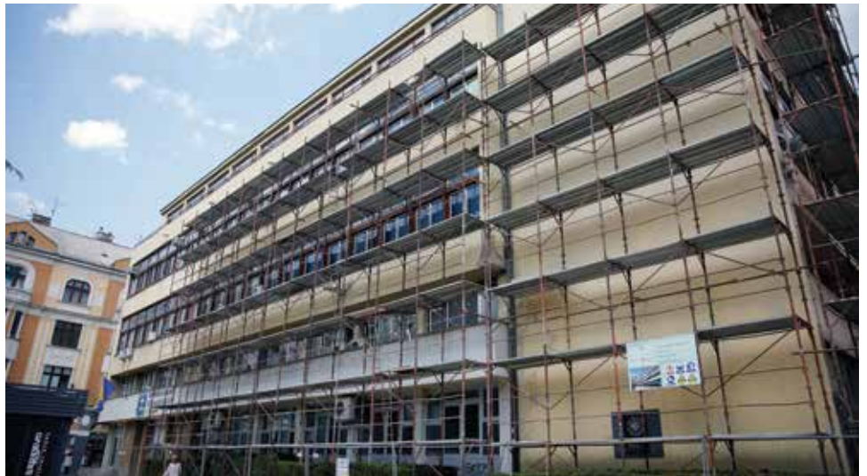
Termoizolacija zidova, stropova i krovova, zamjenu stolarije na Ekonomskom fakultetu
