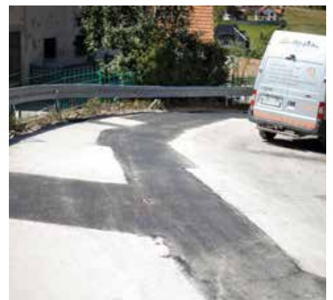
Cjevovod u ulici Sedrenik
