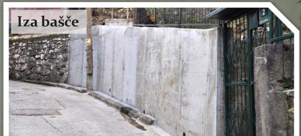
Saniran je kameni potporni zid u ulici Iza bašće do broja 2, na Mahmudovcu. Oštećeni dio starog zida je srušen, te je izvršeno betoniranje novog armirano-betonskog potpornog zida, dužine 10 metara i visine dva metra (5.900 KM).
