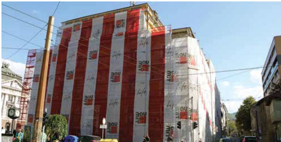
Radovi na obnovi fasade i zamjene vanjske stolarije na JU Srednja škola poljoprivrede, prehrane, veterine i uslužnih djelatnosti Sarajevo
