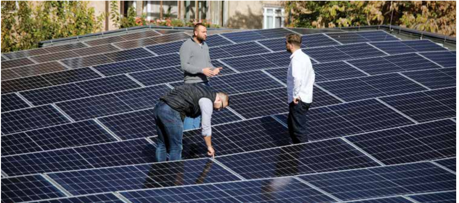
Izgradnja fotonaponske elektrane na krovu administrativnog objekta Općine Stari Grad Sarajevo
