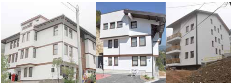
Do sada izgrađene Socijalne zgrade na Brusuljama, Baruthani i Čadordžinoj
