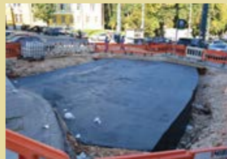
Sanacija stropne ploče
