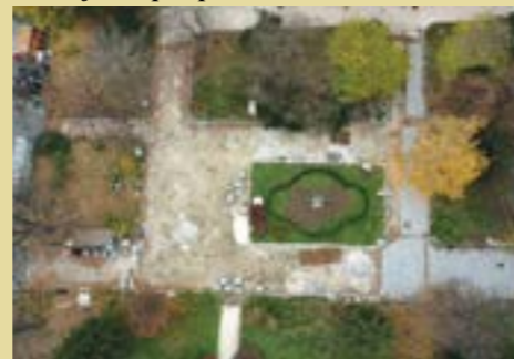
Radovi se uskoro nastavljaju
