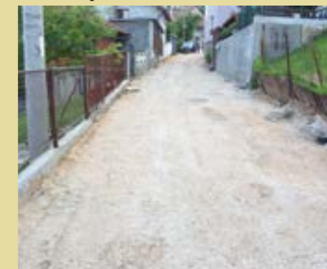
Kamenica - pripreme za asfaltiranje
