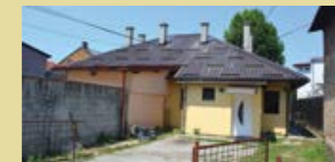
Jedna od saniranih kuća
