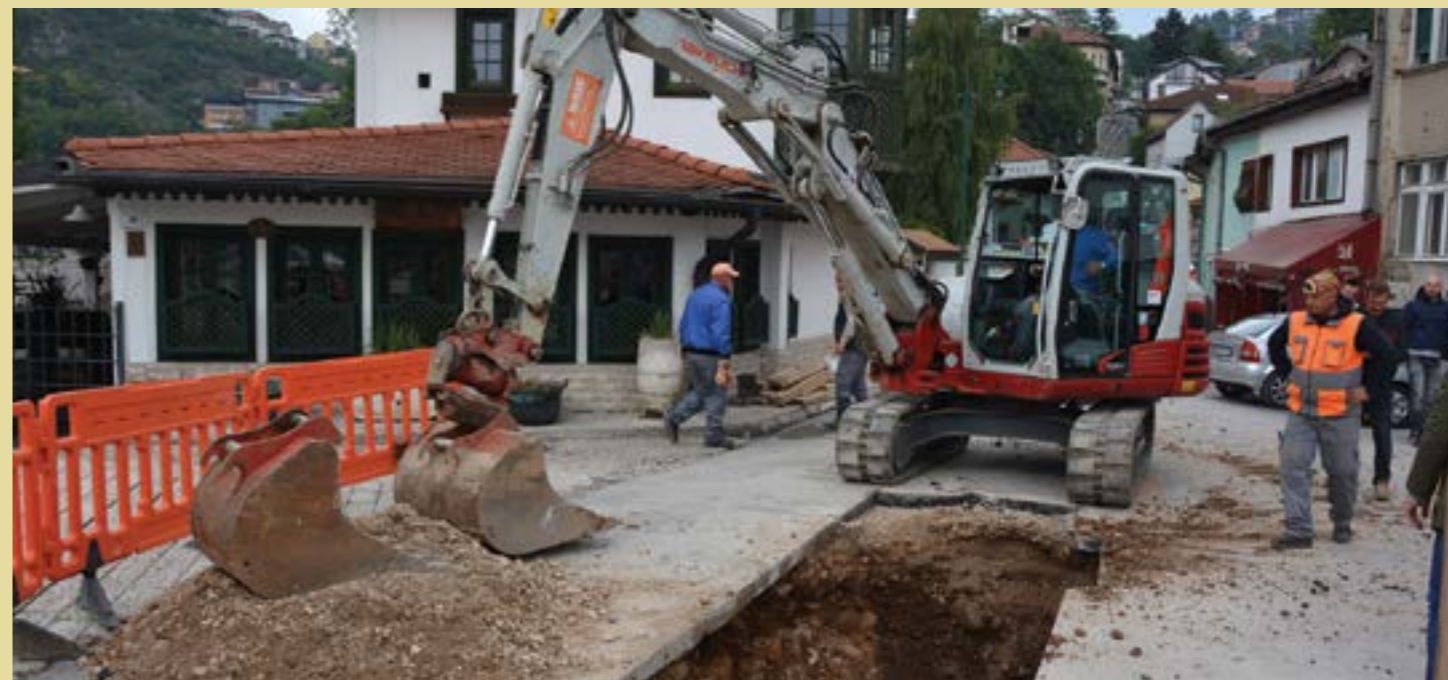
Nova kanalizaciona i vodovodna mreža na Alifakovcu
