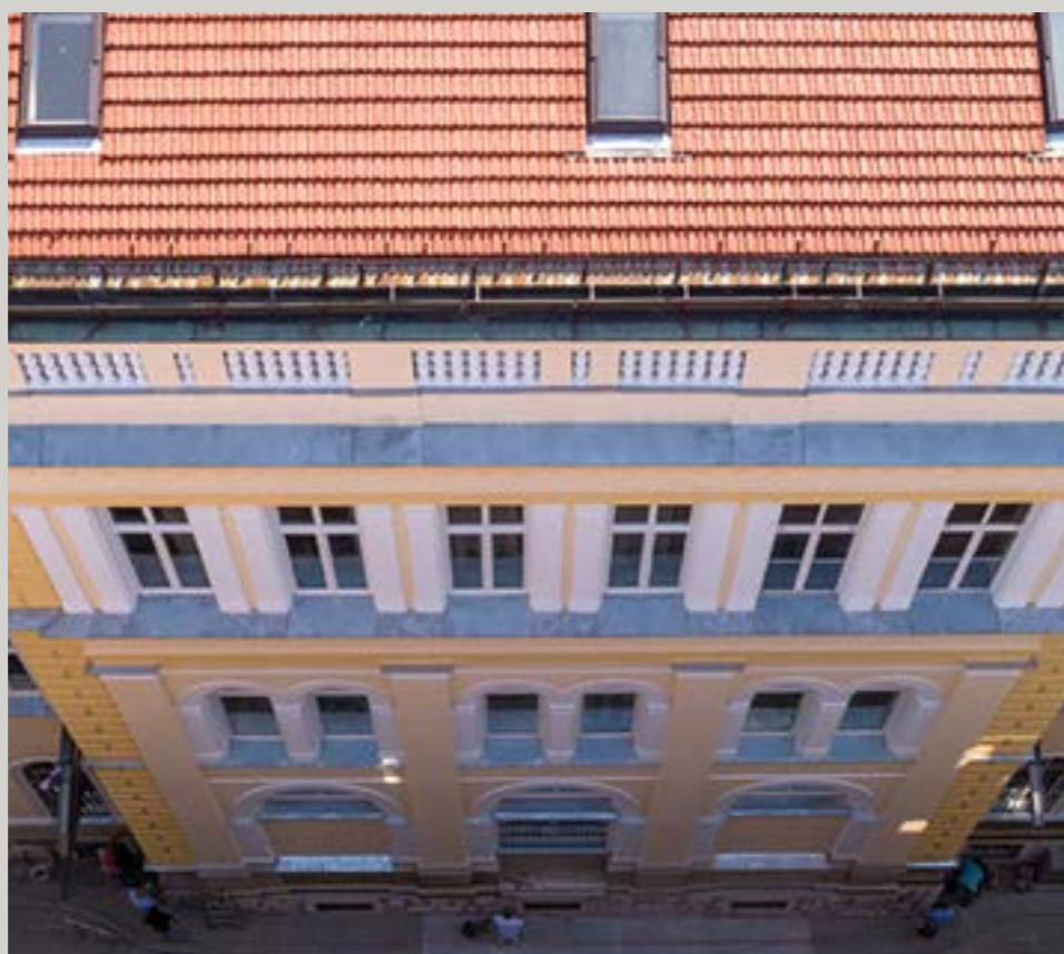
Sanirana zapadna strana fasade
