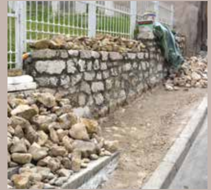
Radovi od Mahirove pekare do Saburine ulice
