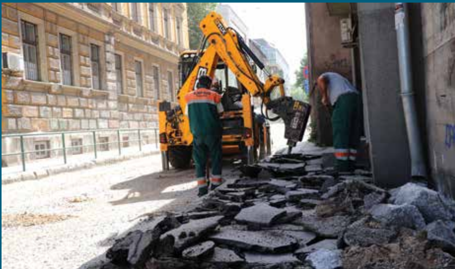
Rekonstrukcija saobraćajnice i trotoara
