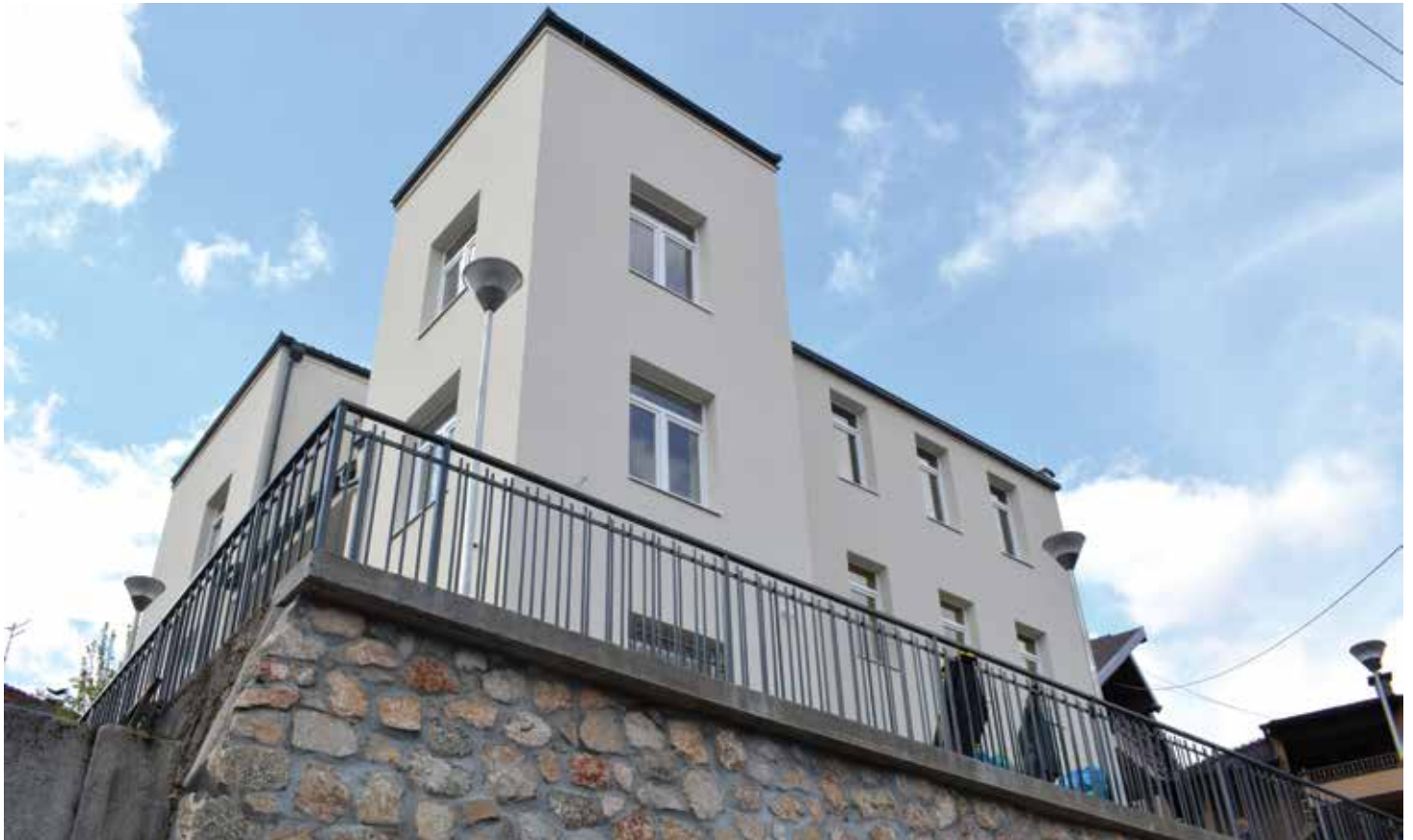
Potpuno rekonstruisan objekat ukupne površine 400 m 2
