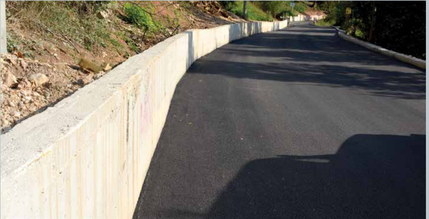
Potporni zid dužine 105 metara na dionici puta Dariva - Hreša
