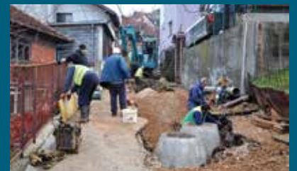
Radovi u toku
