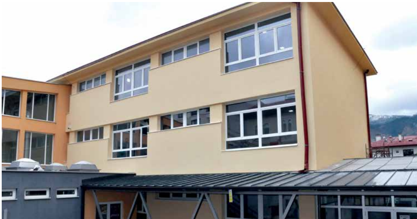
Obnovljena fasada, stolarija i krov, projekat vrijedan 450.000 KM
