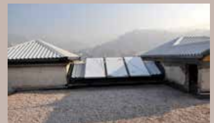
Završeni radovi na krovnoj konstrukciji
