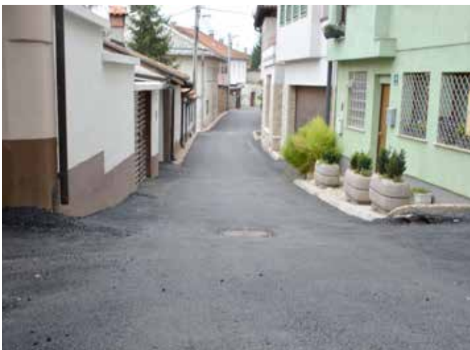
Halilbašića - Projekat je obuhvatao sanaciju ukupno 220 metara ove ulice. Također, željela se sačuvati autentičnost izgleda ulice, te je urađena i sanacija oko 100 metara oštećenih kaldrmisanih trotoara.
