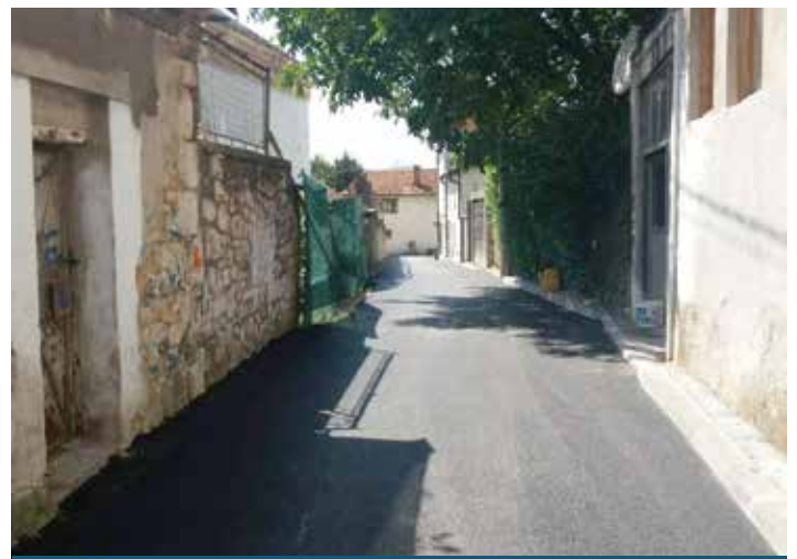
Bijela česma - Ulica Bijela česma na Vratniku, kojom svakodnevno saobraća veliki broj vozila i pješaka, dobila je novi asfalt. Sanacija ulice urađena je na dužini od oko 100 metara.
