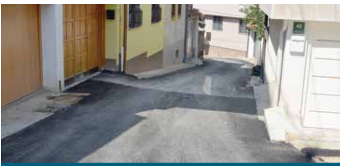
Hasana Kaimije - Urađena je sanacija ulice u dužini od 233,50 metara. Zbog lošeg stanja vodovodne mreže pristupilo se i zamjeni vodovodnih cijevi, a finansirali su je Općina Stari Grad i KJKP "Vodovod i kanalizacija".
