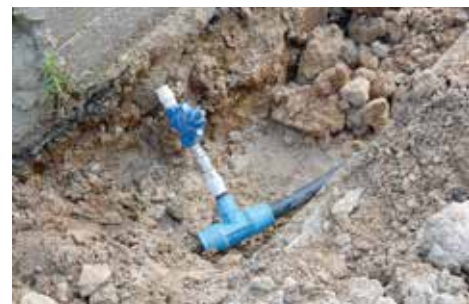
Radove izveo KJKP 'Vodovod i kanalizacija'
