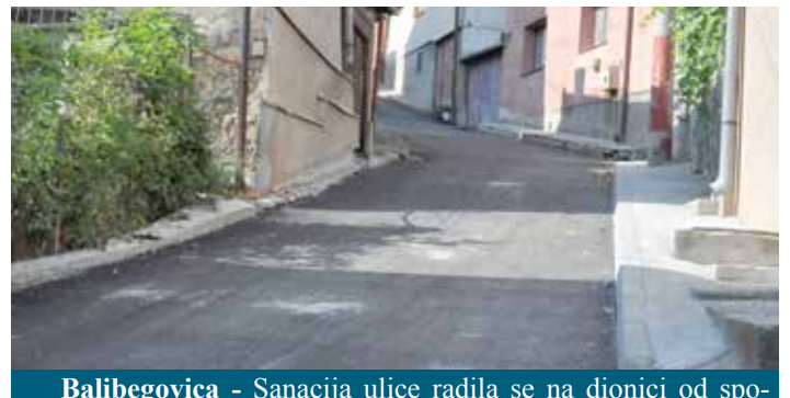
Balibegovica - Sanacija ulice radila se na dionici od spoja ulice Berkuša mala do područne Osnovne škole 'Edhem Mulabdić' koja se nalazi na Bistriku. Ukupna dužina ulice na kojoj se radila sanacija je oko 270 metara.
