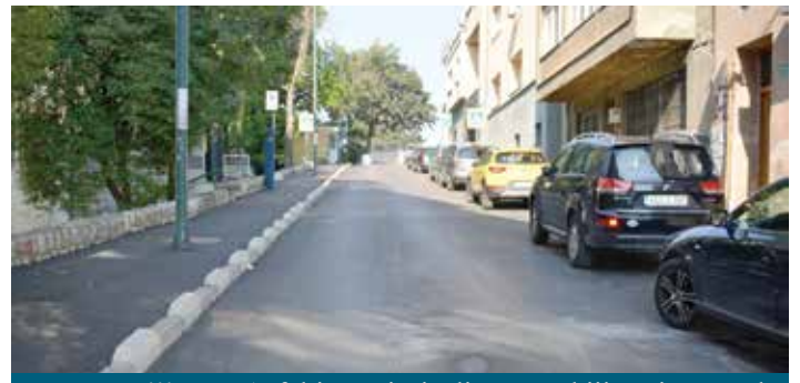
Petrakijina - Asfaltirana je i ulica Petrakijina, inače vrlo prometna saobraćajnica koja povezuje starogradsku jezgru sa poznatim naseljem Mejtaš. Ulica je sanirana u cijeloj svojoj dužini od 220 metara.
