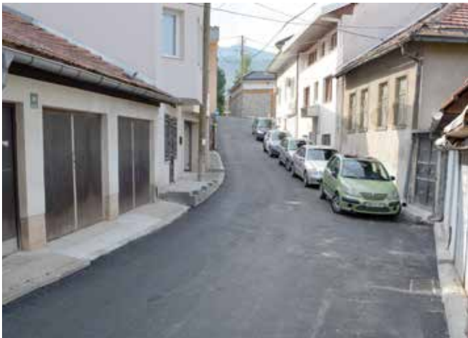
Očaktanum - Radila se sanacija 550 metara ulice. Uklonjen je stari dotrajali asfalt, stari šahtovi, slivnici i slivničke rešetke i na kraju urađeno asfaltiranje ulice.
