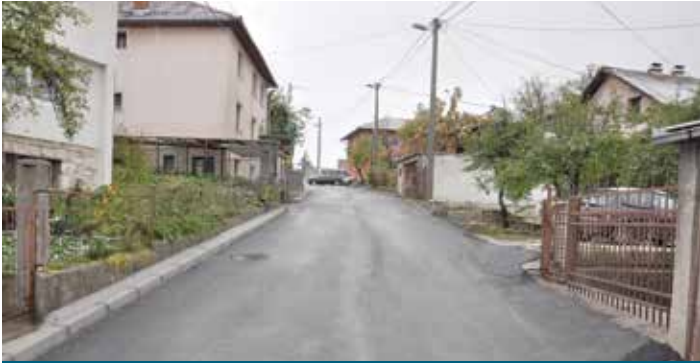
Rogina - U ovoj ulici urađeno je uklanjanje starog asfalta, postavljanje novih ivičnjaka, izrada drenaže za odvodnju oborinskih voda, tamponiranja terena, te asfaltiranje oko 220 metara ulice.
