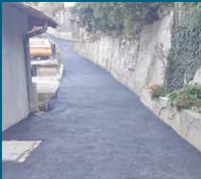
Sanirana ulica na Toka – Džeki
