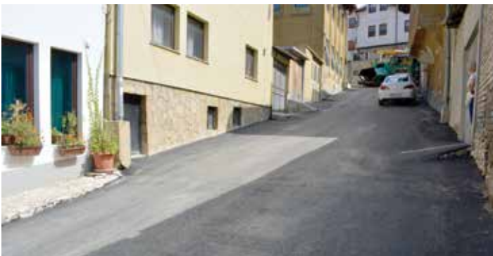
Hrvatin - Ulica je nakon mnogo godina sanirana cijelom svojom dužinom od 220 metara. Prije samog asfaltiranja urađeno je nivelisanje šibera, šahtova, te postavljanje slivnika.
