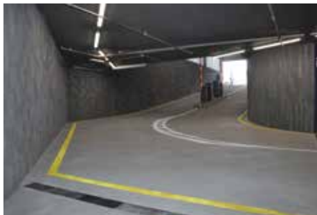
Ulaz iz pravca mosta
