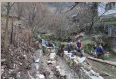
Radovi u toku
