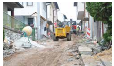
Zamjena kanalizacionih cijevi
