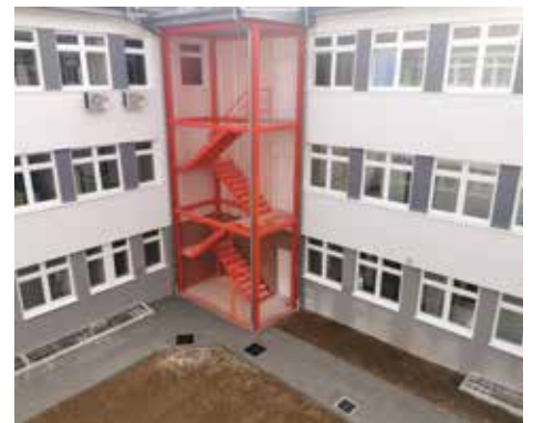
Nove protivpožarne stepenice
