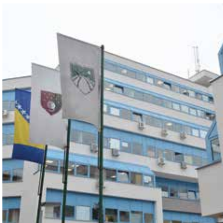
Urađeno utopljanje zgrade Općine
