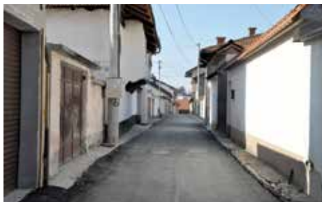
Novi asfalt na 323 metra
