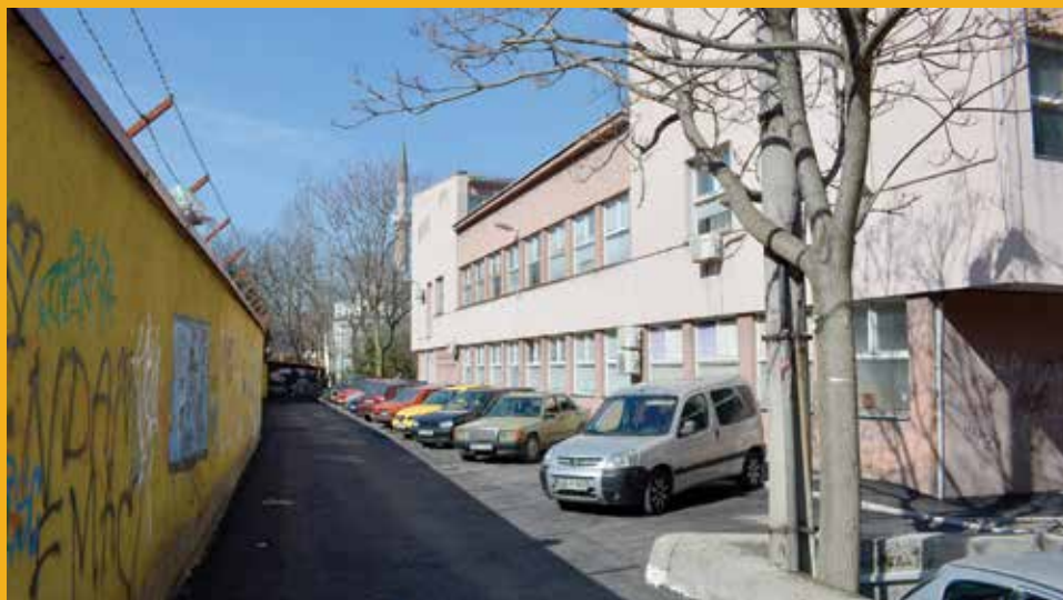
Urađena drenaža i asfaltiranje prostora
