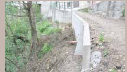
Na mjestu starog izgrađen novi zid
