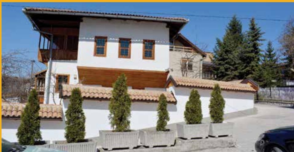
Izgrađen novi, natkriveni ogradni zid
