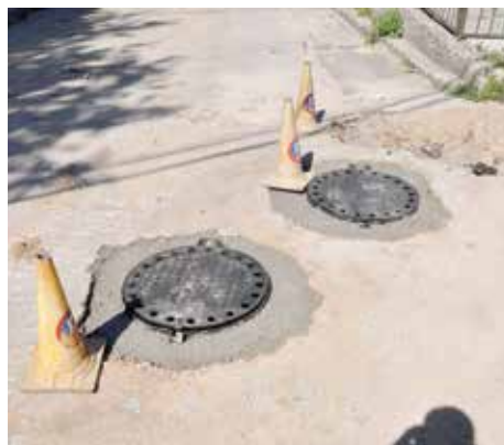
Postavljeni novi šahtovi
