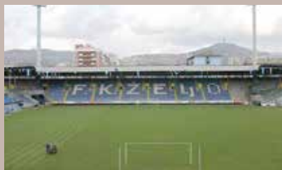
Izgradnja istočne tribine stadiona Grbavica
