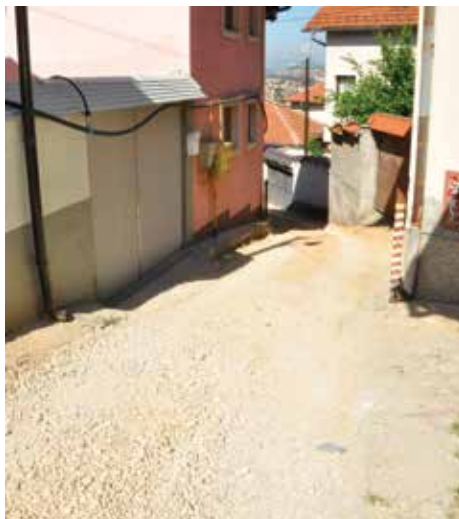
Završeno postavljanje kanalizacione mreže
