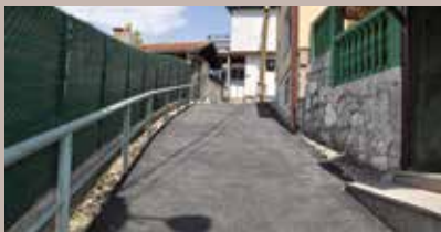
Sanirano 83 metra ulice
