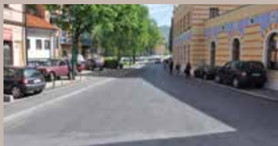
Novi asfalt na dijelu ulice
