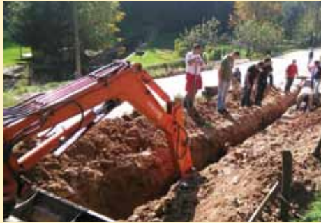
Kanalizacija na Novoj Baruthani
