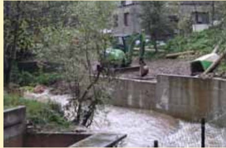
Kanalizacija na Mošćanici
