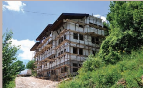
U toku postavljanje fasade
