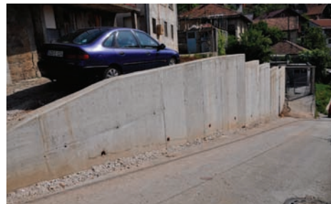
U Ramića banji izgrađen zid dužine 26 metara
