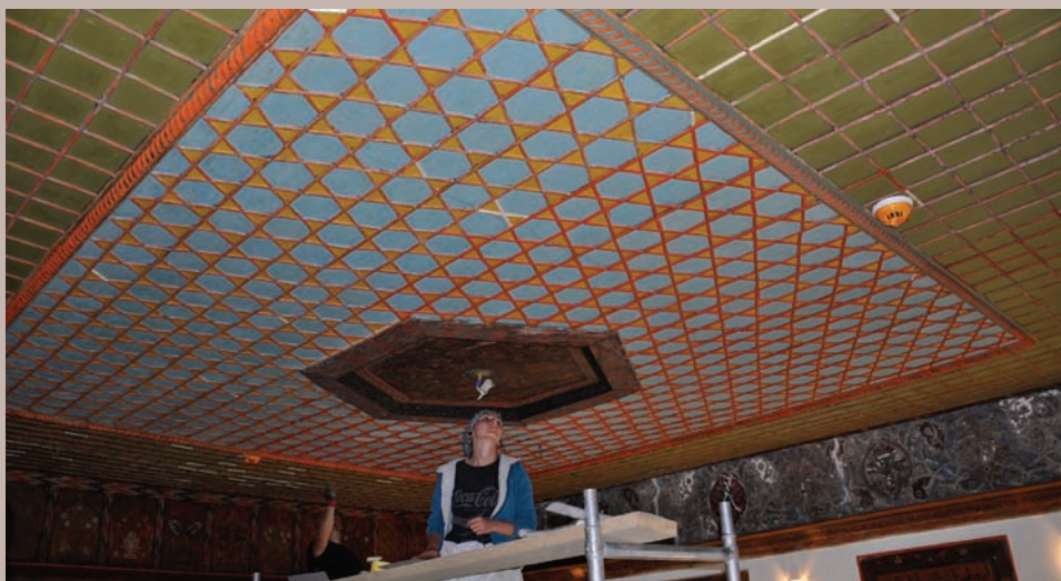
Restauracija unutrašnjosti objekta
