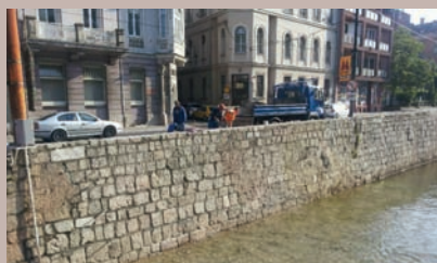
Saniran zid u koritu rijeke Miljacke
