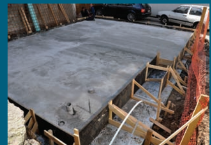
U toku postavljanje izolacije
