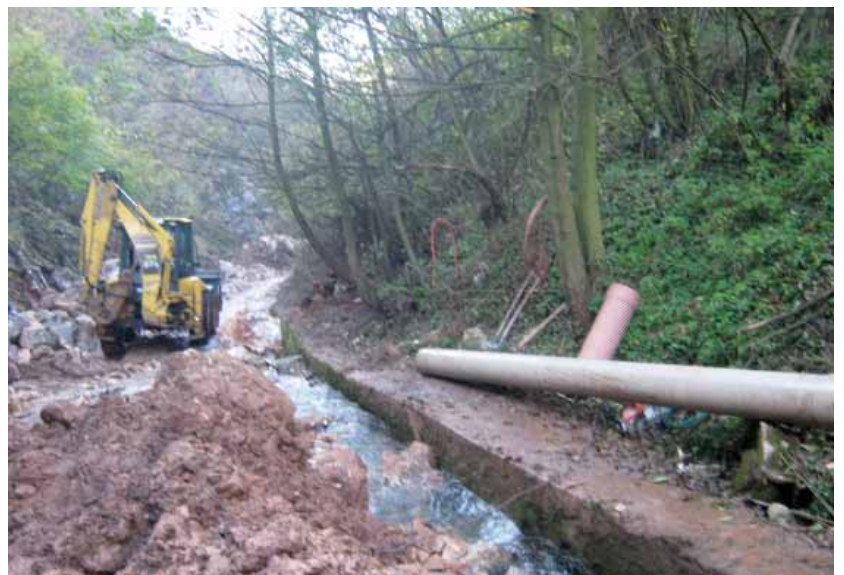
Postavljanje primarne kanalizacione mreže
