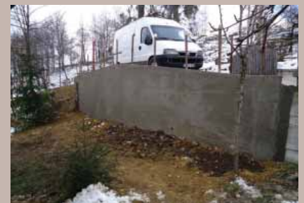
Novi zid dug osam metara
