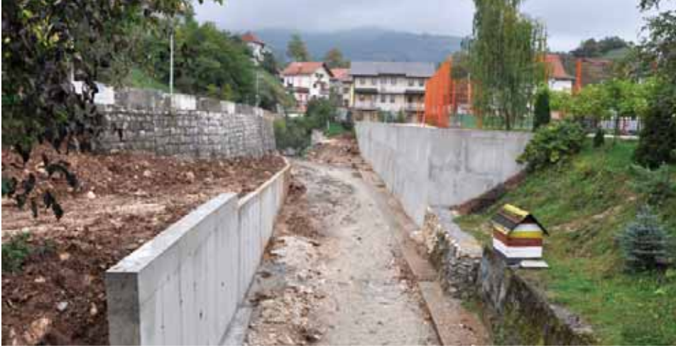
Dva nova zida u koritu Moščanice
