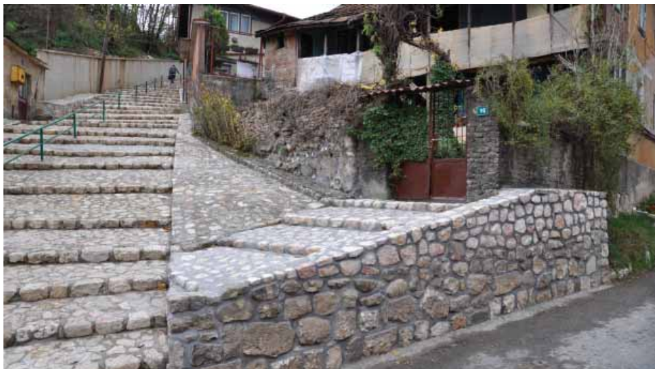
U ulici Save Skarića novi zid, ograda i odvodnja voda
