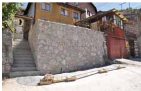
Uz zid izgrađene i stepenice
