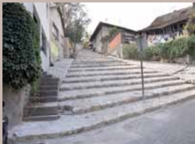
Sanirano gazište kamene kaldrme
