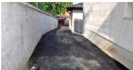
Asfaltirano je 65 metara ulice
