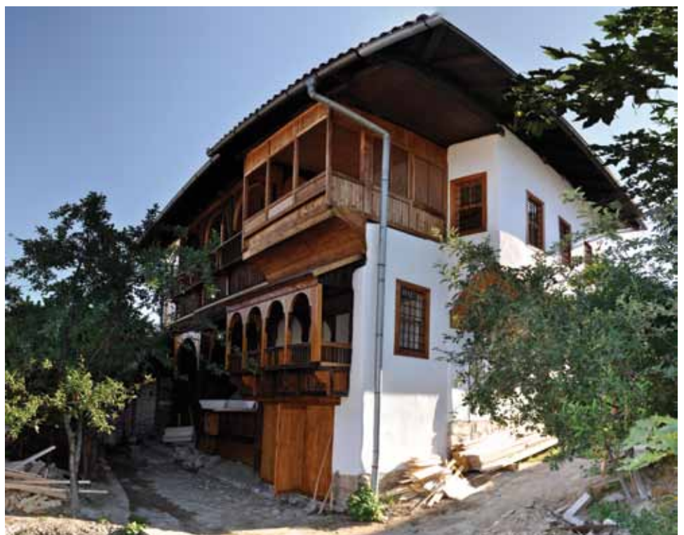
Nova elektro i vodovodna mreža u Saburinoj kući
