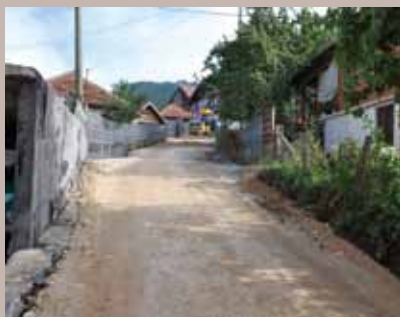
Pripremljena podloga za asfaltiranje
