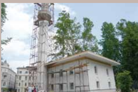
Izgradnja džamije u završnoj fazi
