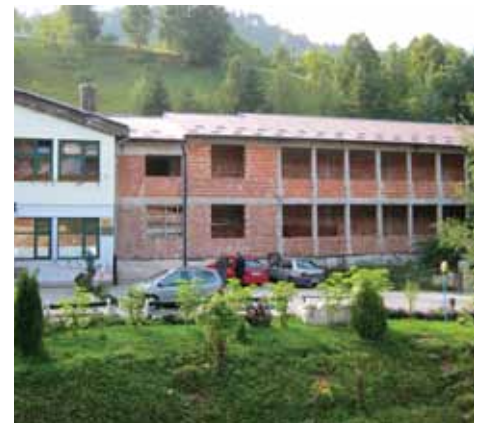
O.Š. "Vrhbosna"- nova krovna konstrukcija na dograđenom dijelu
