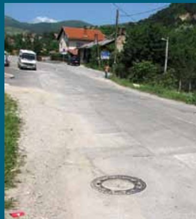
Počinje rekonstrukcija saobraćajnice
