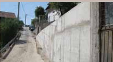
Potporni zid Ramića banja br. 34
