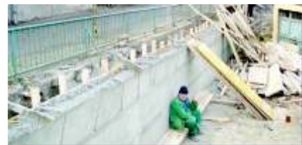
Potporni zid na Hridu
