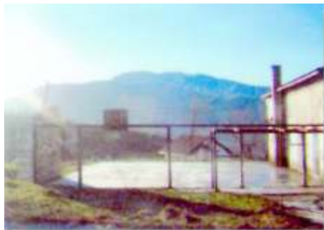
Prije početka izgradnje
