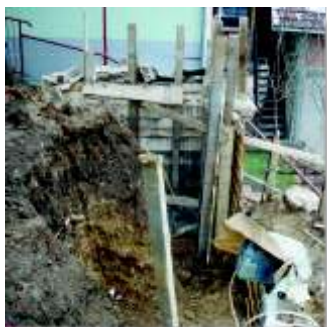
Izgradnja potpornog zida Iza Bašce 2a
