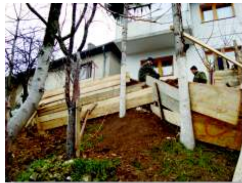
Izgradnja potpornog zida Iza Bašce 2a
