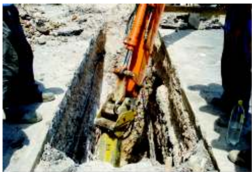
Radovi na kanalizacionoj mreži
