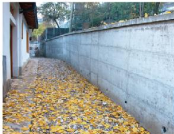
Srušen stari i izgrađen novi zid
