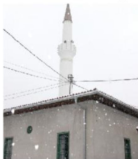
Saniran krov i munara
