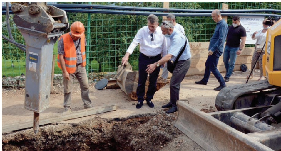
Radovi u toku
