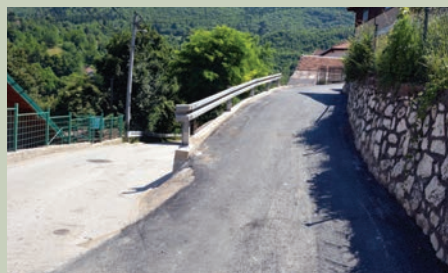
Novi asfalt na 420 metara ulice
