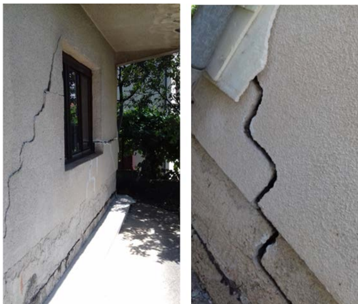
Slika 1 i 2: Oštećenja na stambenom objektu unutar klizišta K-7
