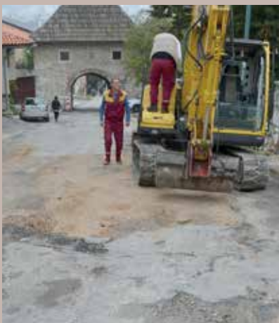
Rekonstrukcija ulice Širokac
