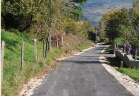
Sanirana ulica Dolovi
