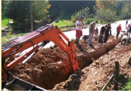
Kanalizacija na Novoj Baruthani
