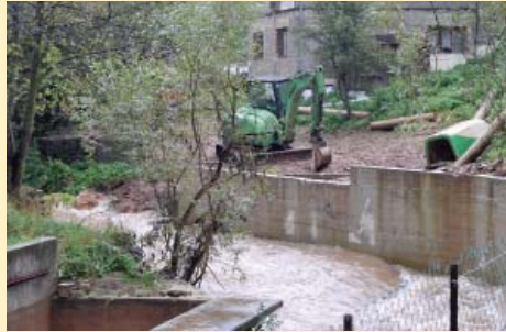
Kanalizacija na Mošćanici
